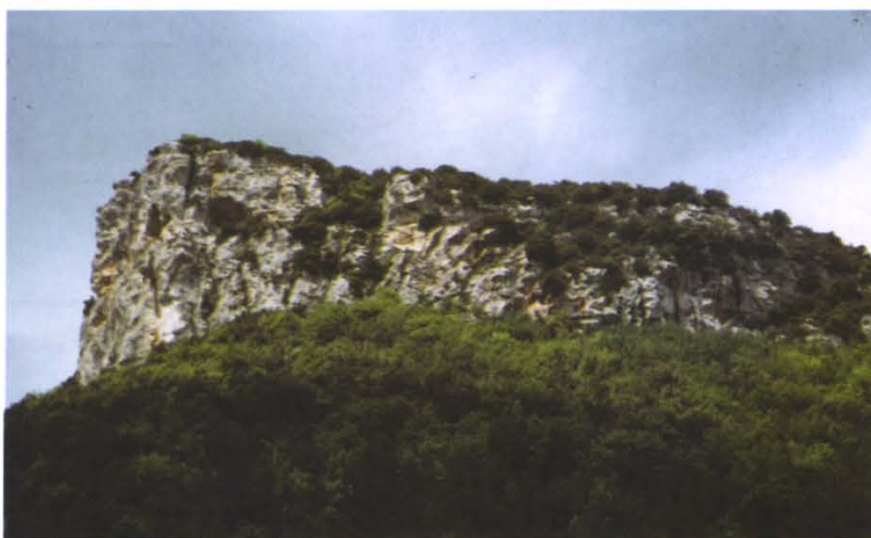
La Rocca di Corno, sotto cui si sviluppa il traforo idrogeologico tra Valle dei Ponci ed Acquaviva (foto G. Calandri).
