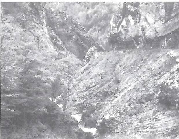
Il paravalanghe in metallo presso le Arme del Lupo (foto G. Calandri)
