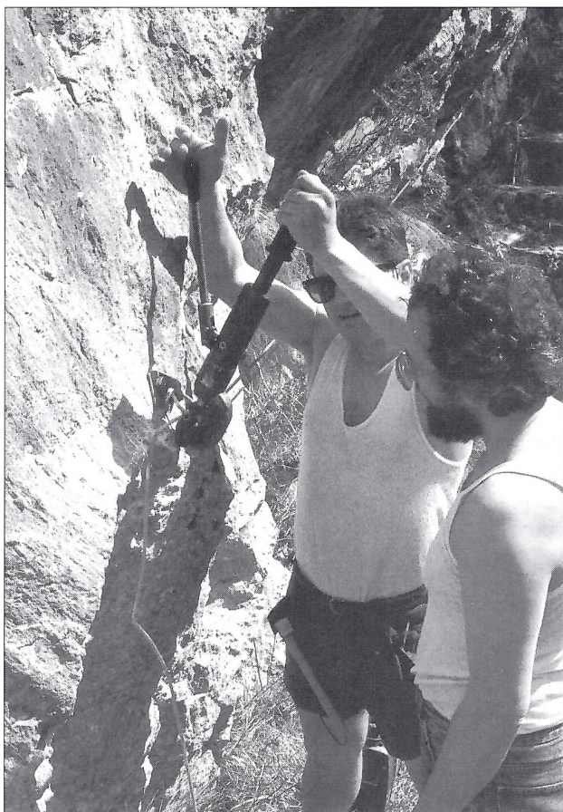
Lavori di ripristino del sentiero (foto G. Calandri)
