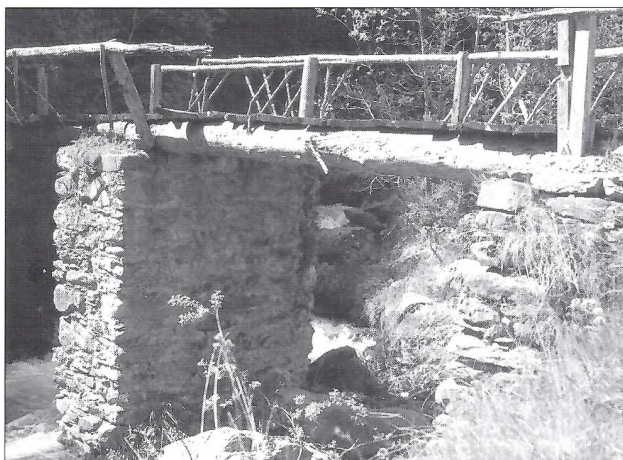
Il vecchio ponte sul Rio di Upega (foto G. Calandri)
