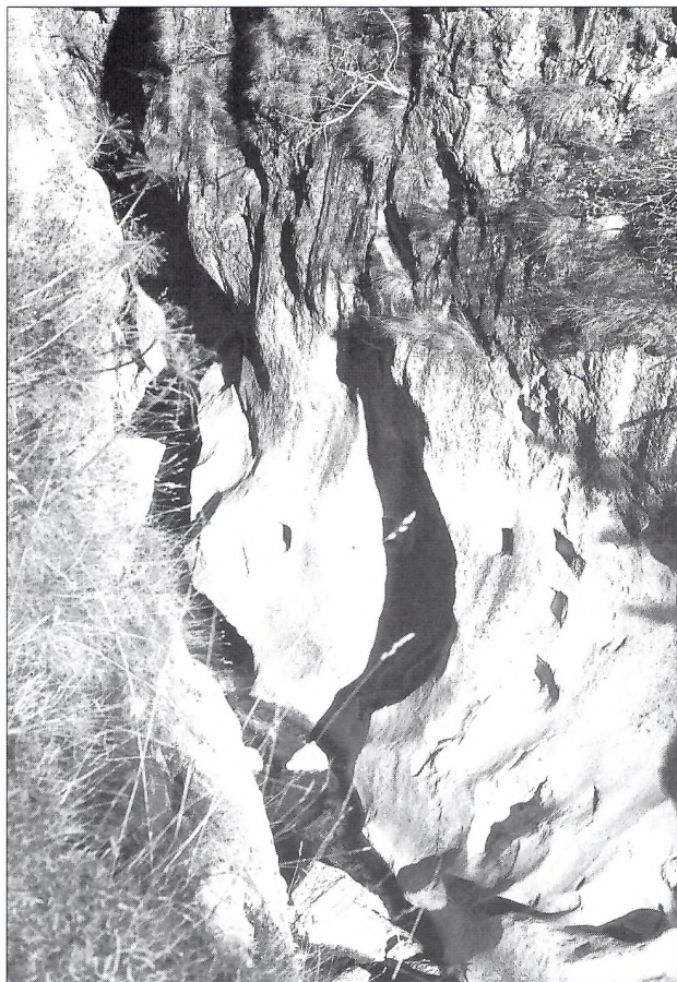
Gli incavi della chiusa delle Fascette per la fluitazione del legname (foto G. Calandri)
